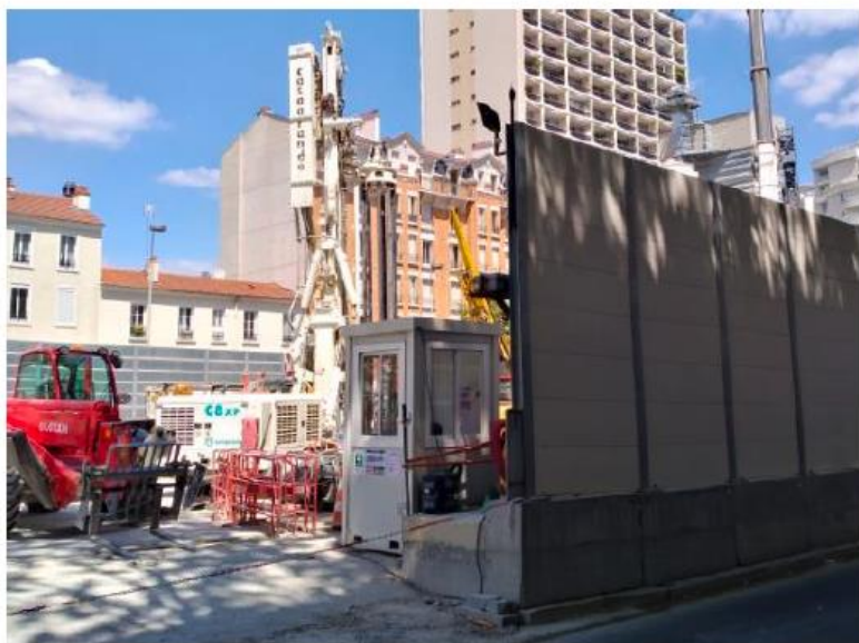
Ecran absorbant provisoire mis en œuvre en limite d'emprise du chantier (source : Acoustb)
