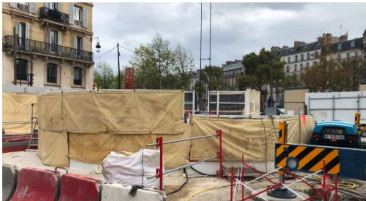
Bâches installées autour d'un atelier bruyant de courte durée
