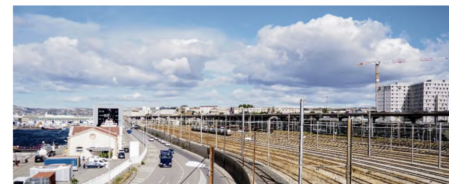
Figure 6 : Le faisceau d'Arenc (à gauche, le Bd du Radoub)
