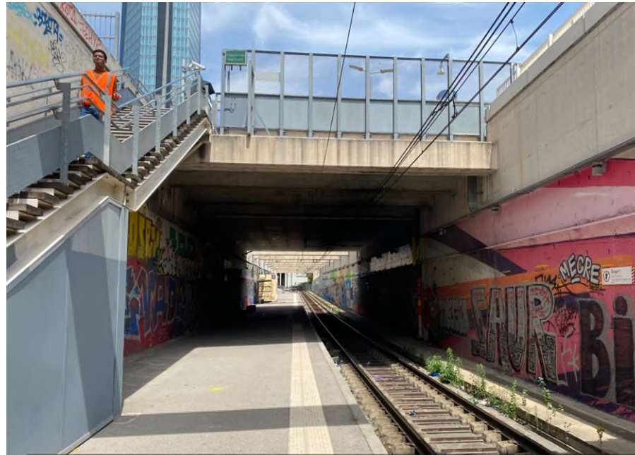
Figure 3 : Dalle existante d'accès au quai – Vue depuis le quai existant (Source : SETEC)
