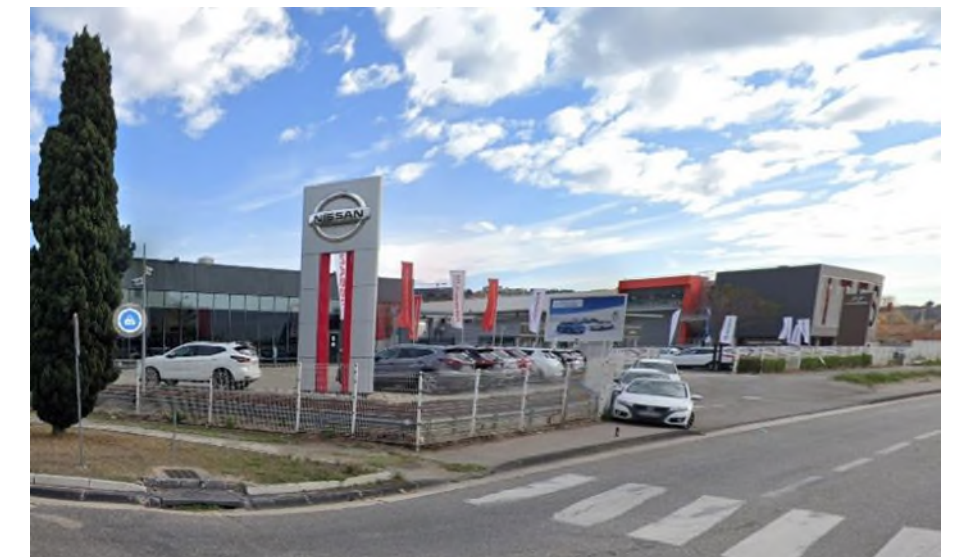
Figure 27 : Site d'implantation de la halte et du pôle d'échanges de Saint-André (source : google maps)
