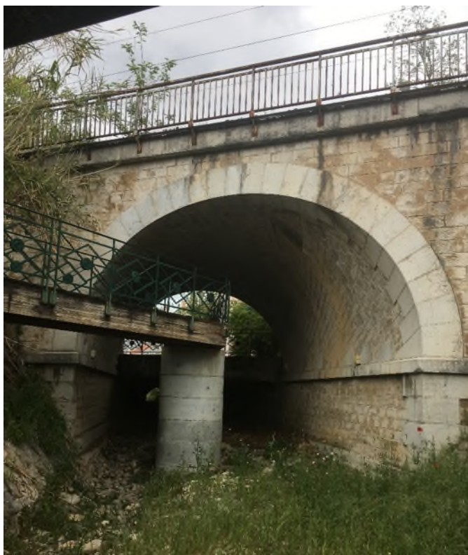
Figure 41 : ouvrage hydraulique du Dégoutant (Egis, 2021)
