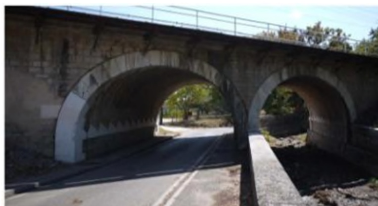
Figure 44 : Photo du ruisseau le Réganas à la traversée de la voie ferrée - (source : Systra, septembre 2015)
