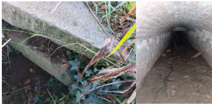
Figure 42 : Entrée du ruisseau dans la section enterrée sous la gare et aperçu intérieur de l'ouvrage
