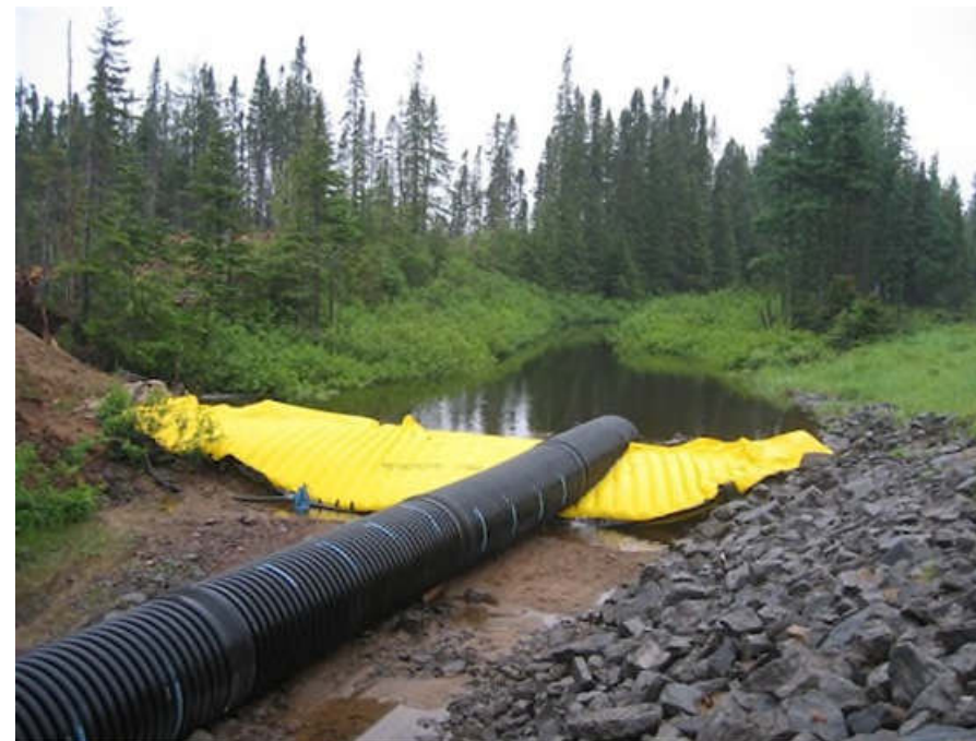
Figure 66 : exemple de batardeau souple mis en place dans le cadre de travaux en rivière
