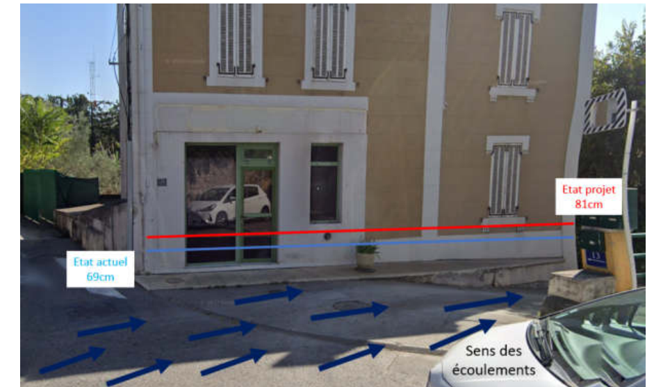
Figure 50: Ligne d'eau sur l'habitation au croisement D66 et quartier de la Gare
