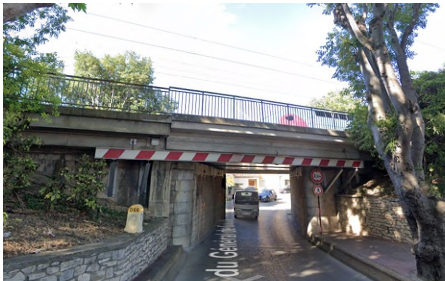
Figure 7 : Vue du PRA CDG (entrée nord) (Source : Google Maps - 2024)
