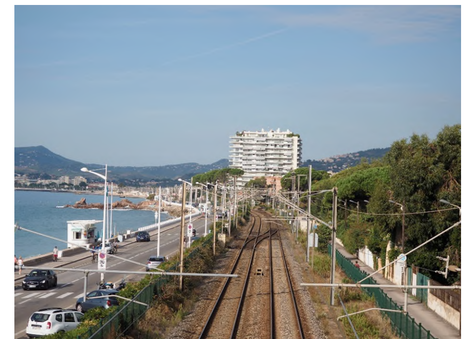
Figure 61 : Bifurcation de la ligne Cannes - Grasse (photo Artelia)
