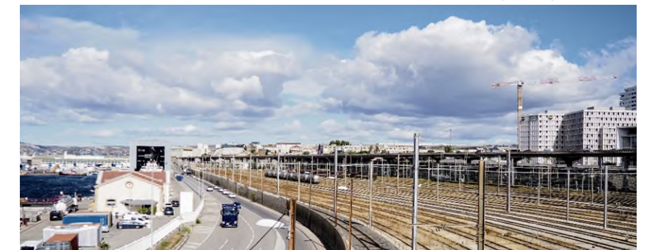
Figure 56 : Le faisceau d'Arenc (à gauche, le Bd du Radoub)
