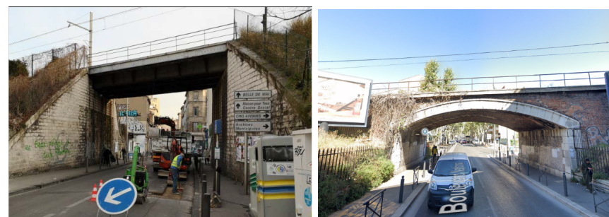
Figure 54 : Pont-rail de la rue de la Belle de Mai, pont-rail du Bd National
