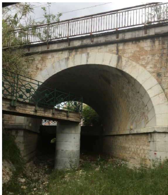
Figure 12 : Reconnaissance in situ d'ouvrage hydraulique
