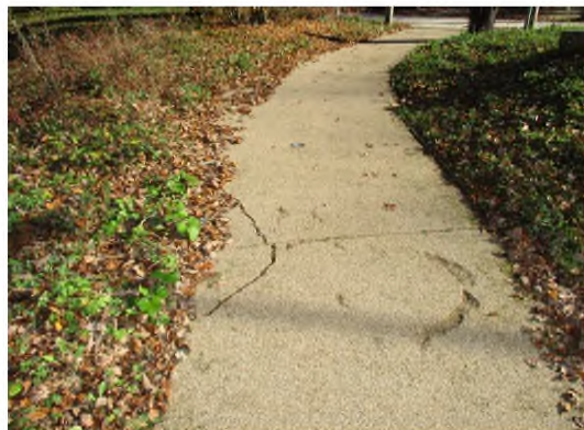
Fig.11 : Ecaillage du revêtement de sol Terraway (Chemineements piétons)
