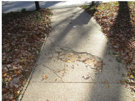
Fig.11 : Ecaillage du revêtement de sol Terraway (Chemineements piétons)
