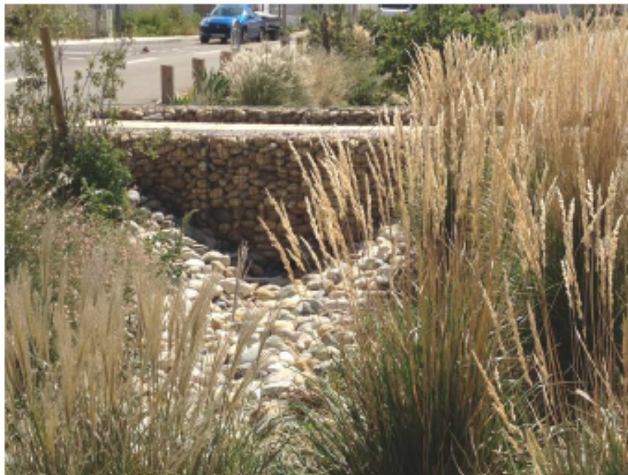
Figure 27 - Noue sèche à Maubec (Notice d'intégration paysagère AREP, 2021)
