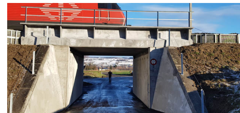
Figure 17 : Béton BFUP pour la construction/reconstruction des tabliers des PRA et PRO
