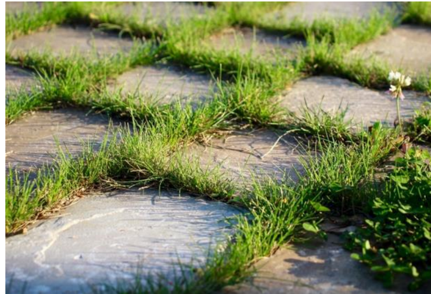
Figure 28 - Pavés engazonnés (Notice d'intégration paysagère AREP, 2021)
