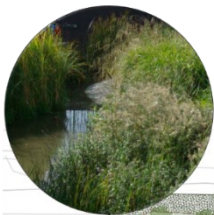
Bassin à ciel ouvert
