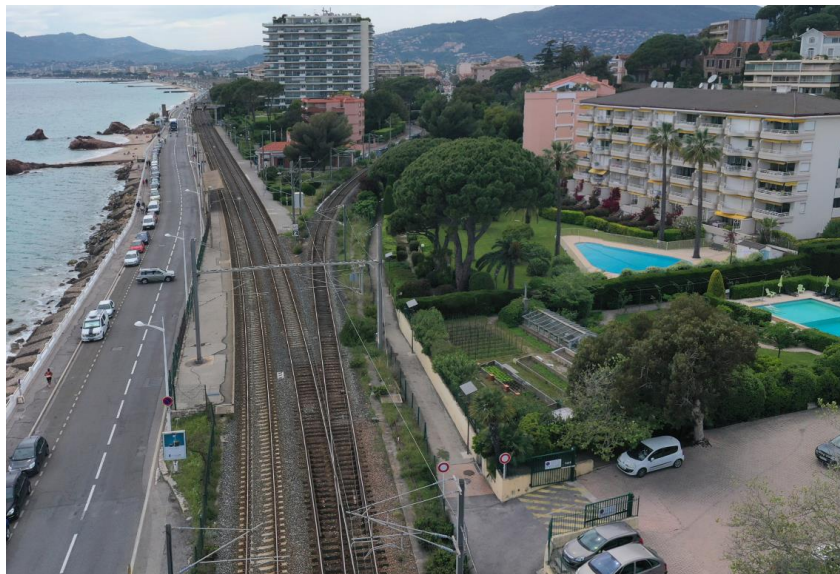
Vue aérienne du secteur de la bifurcation de Grasse
