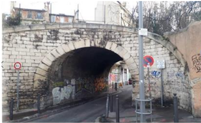
Figure 6 : Pont Rail de la rue Levat (Google, 2021)
