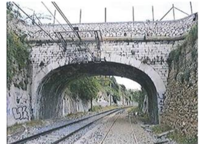
Figure 5 : Pont Route de l'avenue Bellevue dit « en anse de panier » (SNCF, 2014)
