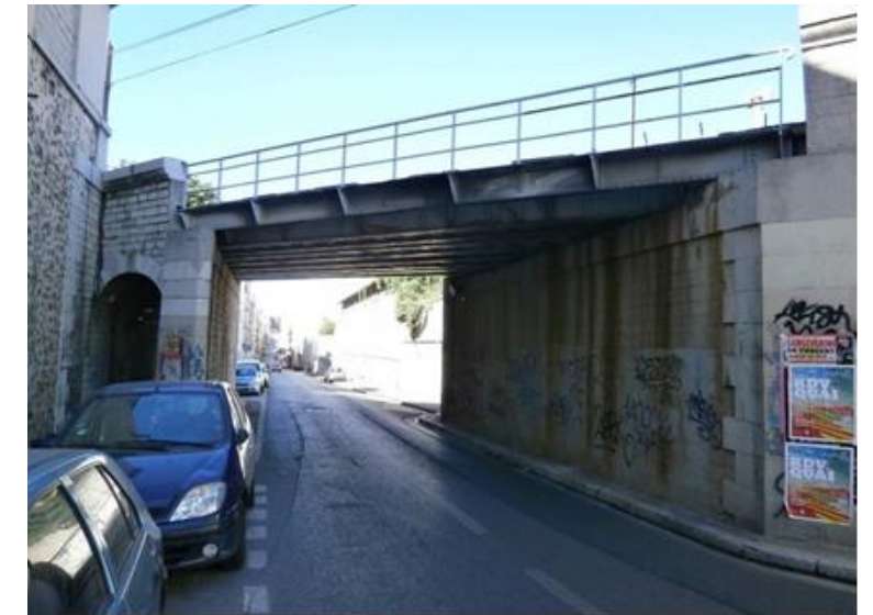
Figure 53 : Pont rail de la rue Guibal (Google, 2021)
