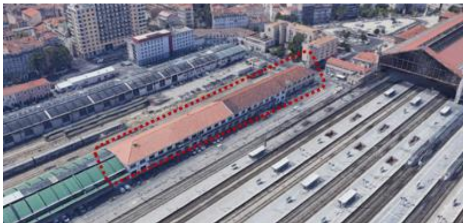
Figure 48 : Partie de la halle A (toiture tuiles) conservée durant la phase 1
