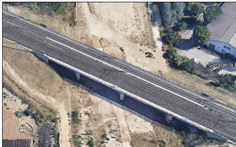
Figure 39 : Pont rail de la L2 (Google Maps, 2021)
