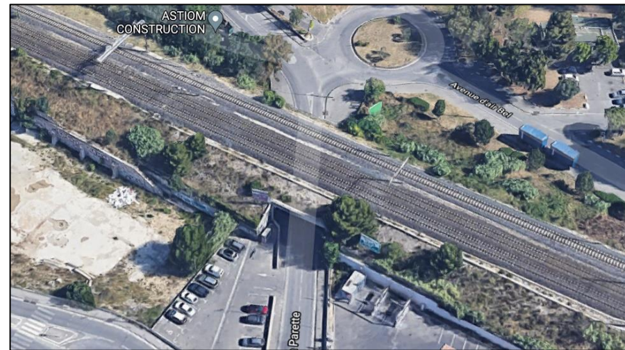
Figure 40 : Pont rail chemin de la Parette (Google Maps, 2021)
