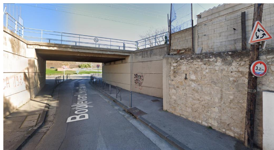
Figure 24 : Photos du pont-rail boulevard Henri Barnier (Google maps)
