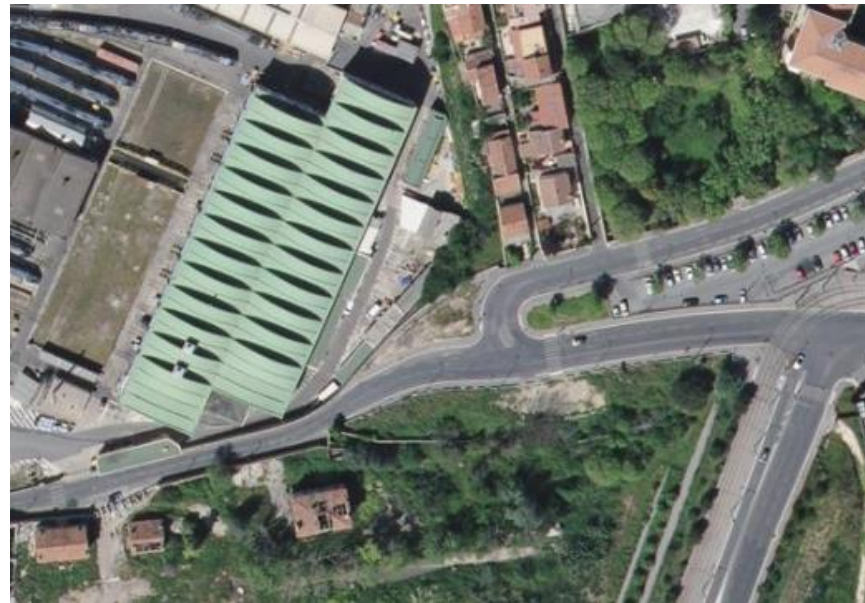
Figure 85 : photo du site de rectification du Chemin de St Jean du Désert (Géoportail)
