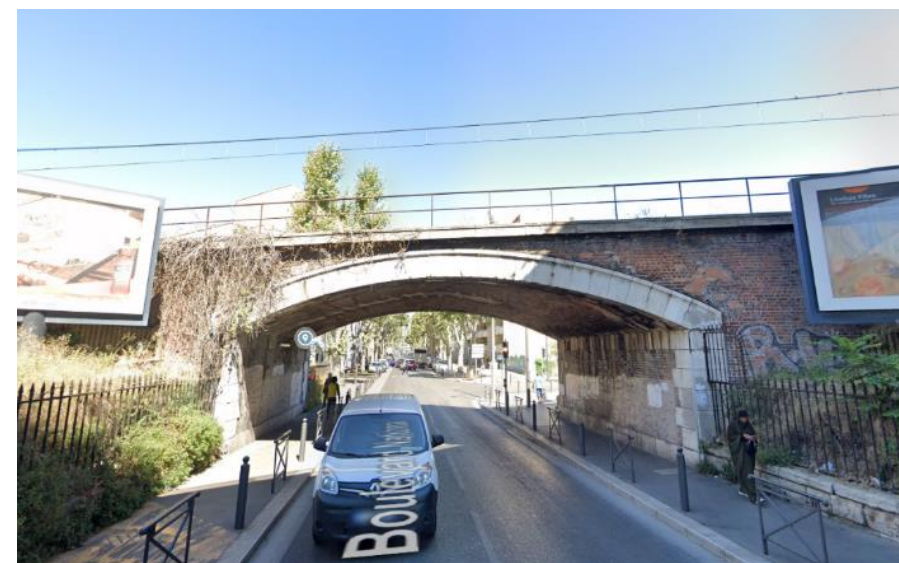
Figure 4 : Pont Rail du boulevard National (Google, 2021)
