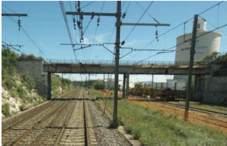
Figure 44 : Passerelle des Maures (EGIS, 2021)
