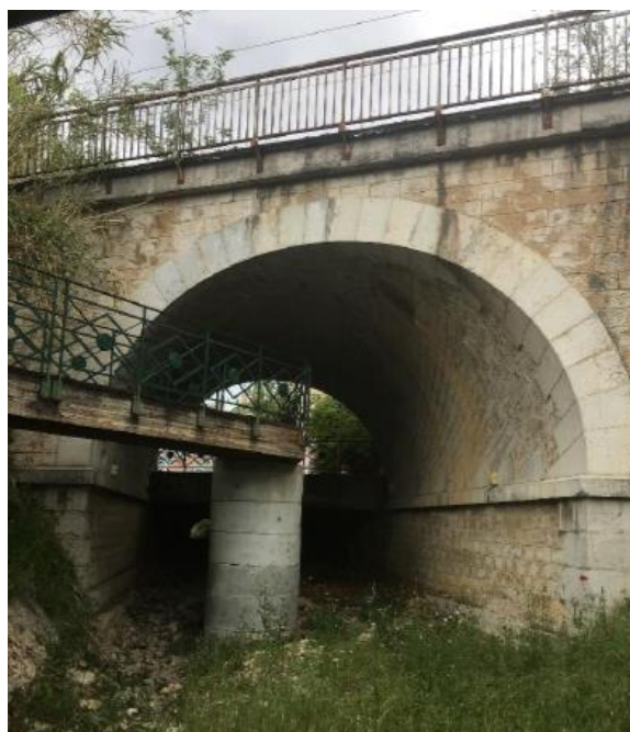
Figure 12 : Reconnaissance in situ d'ouvrage hydraulique
