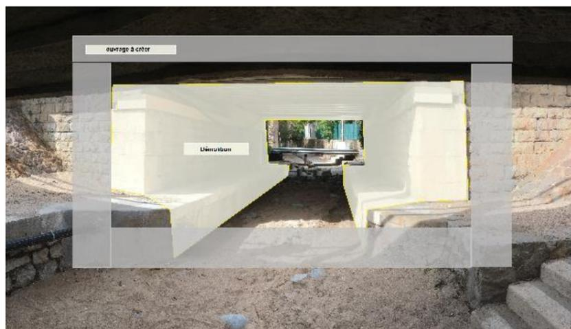
Figure 8 : élargissement de l'ouvrage à 6m (Systra, 2021)
